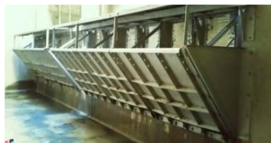
Figure 16. Dégrilleur vertical. Source/crédit : Hydroconcept
