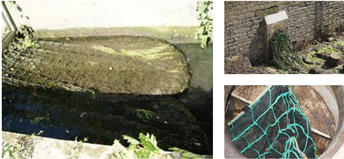
Figure 12. Filets de rétention en place sur Brest Métropole dans cours eau, sortie eau pluviale, et avaloirs (Photos OiEau)
