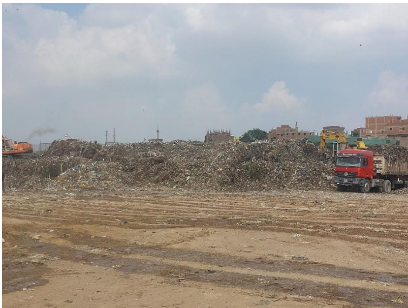
Centre de tri et de traitement des déchets à El-Salem, géré par ECWM
